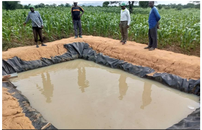
Regenwasser-Auffangbecken als Reserve für Trockenzeiten.
